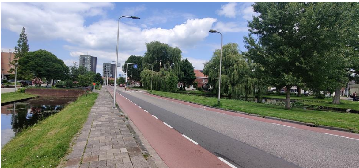
Foto: straatbeeld locatie werkzaamheden vergroten duiker Oranjeplein (bron: Gemeente Gouda)
